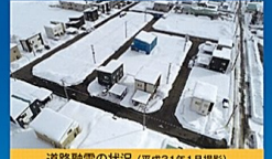
道路融雪の状況(平成31年1月撮影) 団地前の県道は除雪後の寄せ雪があり、アイス バーン状態ですが、団地内道路は融雪機能によ り、まったく雪がありません。
